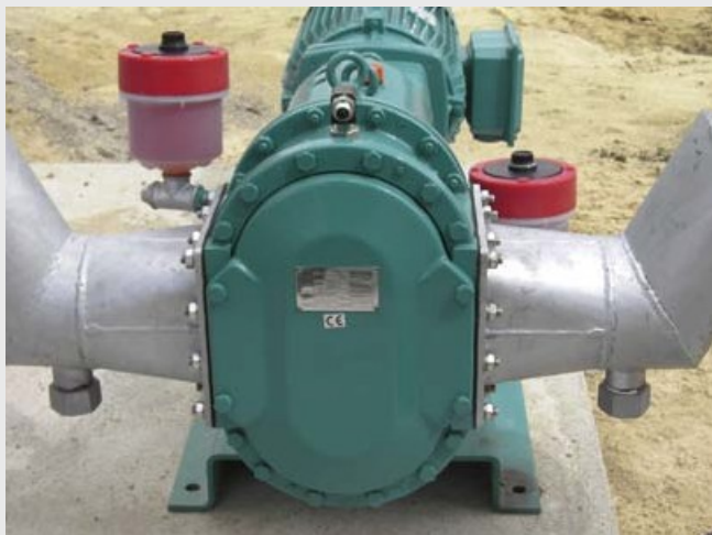
Substrato tiekimo siurblys biodujų jėgainėje. Srautas iki 40 m 3 /h, slėgis iki 2 bar.
