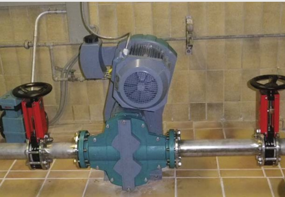
Naudojamas nuotėkų valymo įrenginiuose, TORNADO® T2 dumblą, kuriame yra 2% kietųjų dalelių, siurbia 18 m 3 /h greičiu, esant iki 2 bar slėgiui.
